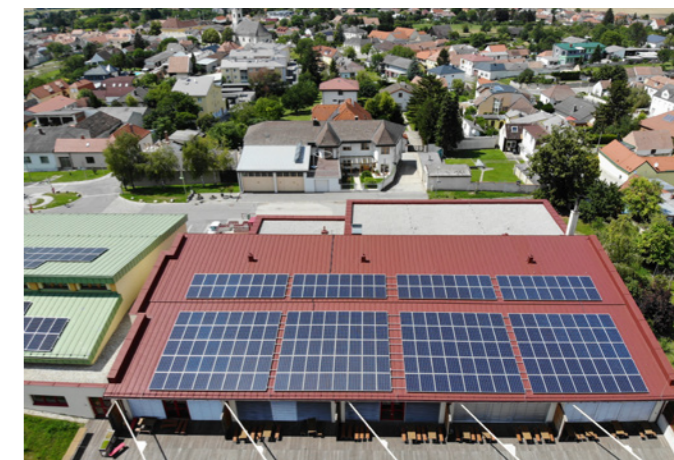
Das Photovoltaik-Bürgerkraftwerk am Dach des Hornsteiner Kindergartens.
