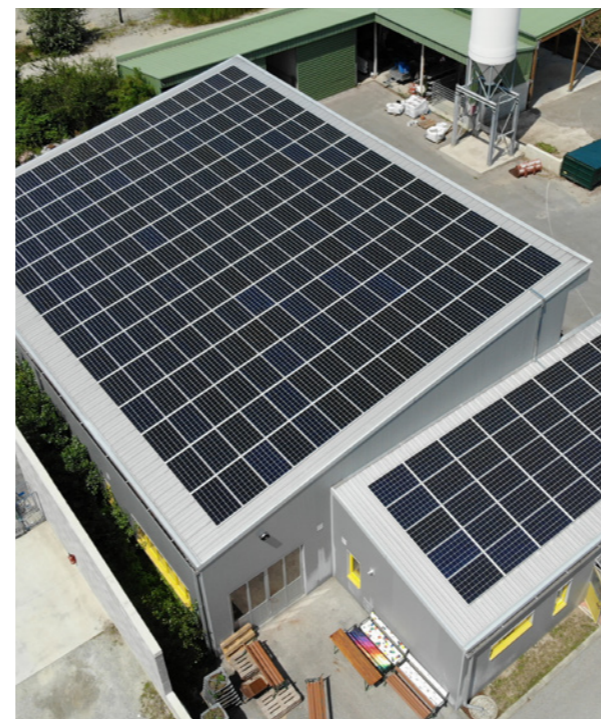
Dach des Gemeinde-Bauhofs
