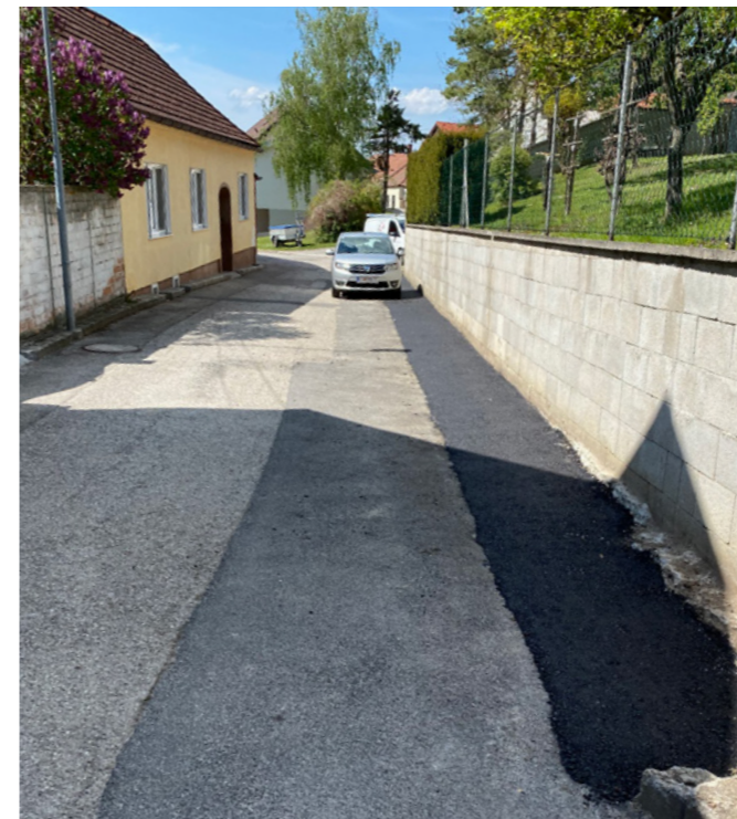
Bauarbeiten Grabengasse: Verbreiterung der Fahrbahn
