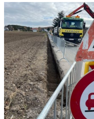
Die Anschlüsse für Kanal, Wasser und Strom werden bereits vorbereitet.
