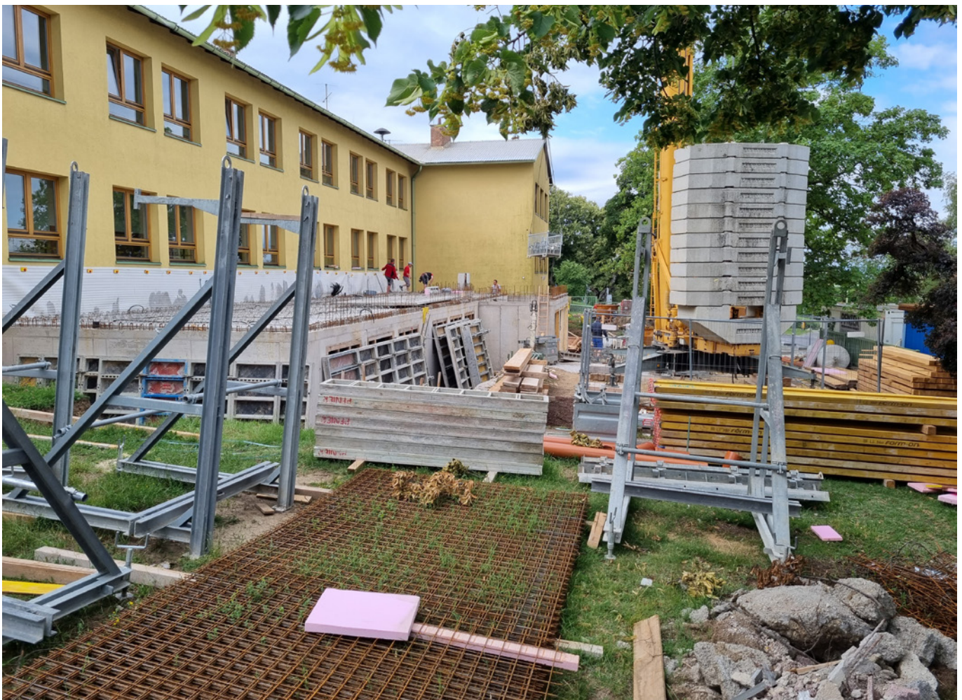
Auf der Baustelle ist der Fortschritt schon deutlich zu erkennen.
