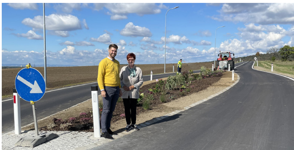
Der Fahrbahnteiler auf der Lorettostraße wurde fertiggestellt und mit der Hilfe von Gemeindevorständin Gertrude Pogats bepflanzt.
