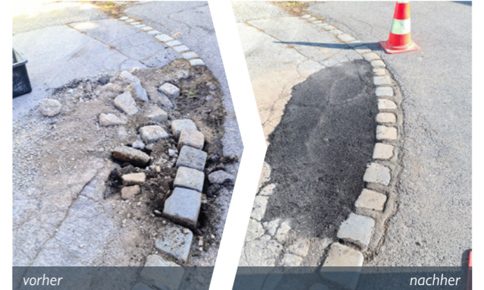
Vor der Mühle in der Mühlgasse wurden lose Pflastersteine befestigt und das entstandene Loch geschlossen.
