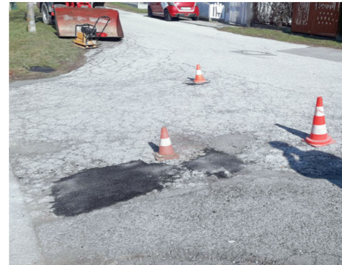
Schlaglöcher in der Eisenstädter Straße wurden geschlossen.
