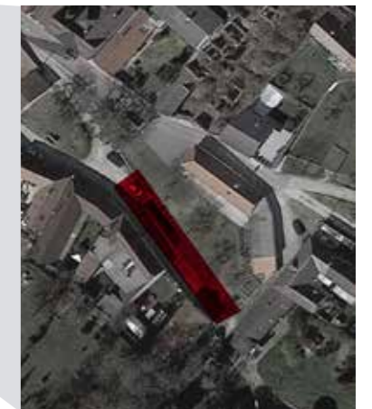
GRABEN Asphaltierungsarbeiten Verbreiterung der Straße
