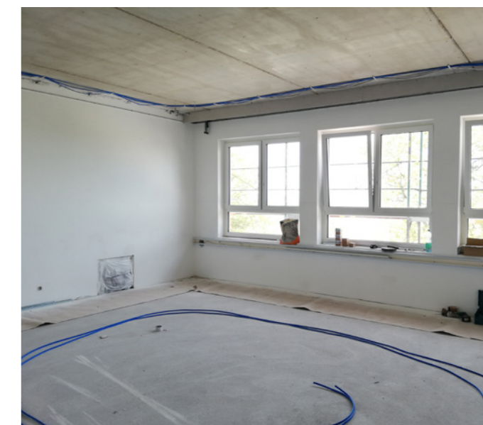
Der Innenausbau der neuen Klassen schreitet planmäßig voran.
