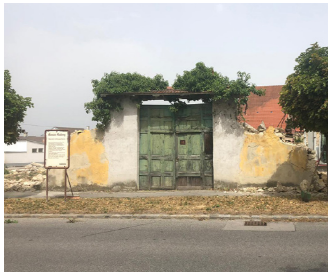
Das historische Tor wird professionell saniert und wieder aufgestellt.
