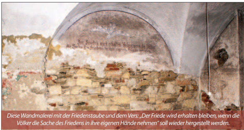
Die Forsthausküche soll saniert werden
