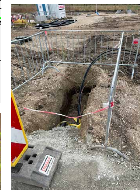
Die Anschlüsse für Kanal, Wasser und Strom wurden bereits verlegt.
